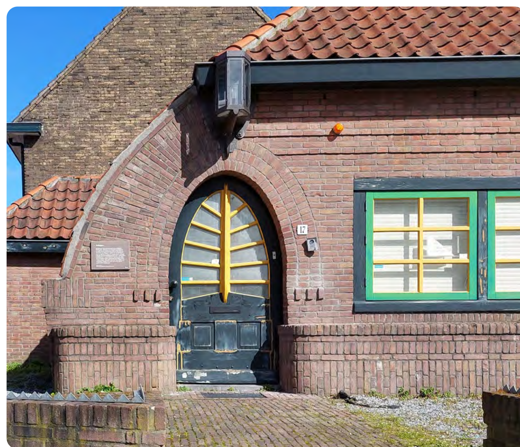
De voormalige politiestation, ontworpen door Dudok aan het groene plein
